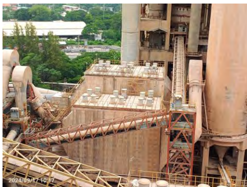
ระบบบำบัดมลพิษ Electrostatic Precipitator ของโรงงาน 2
