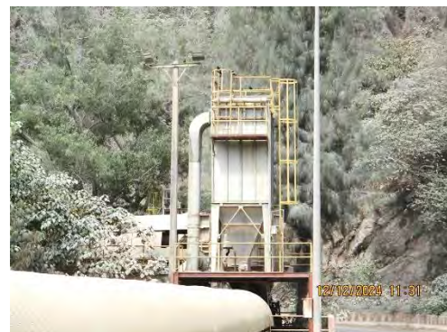
ระบบบำบัดมลพิษแบบถุงกรอง (Bag Filter) โรงงาน 3
