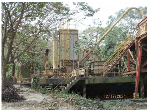
ระบบบำบัดมลพิษแบบถุงกรอง (Bag Filter) โรงงาน 3
