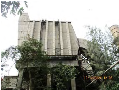
ระบบบำบัดมลพิษ Electrostatic Precipitator ของโรงงาน 3
