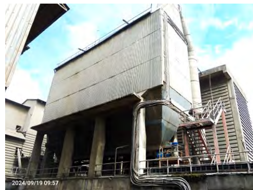
ระบบบำบัดมลพิษ Electrostatic Precipitator ของโรงงาน 2
