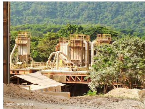
ระบบบำบัดมลพิษแบบถุงกรอง (Bag Filter) โรงงาน 2
